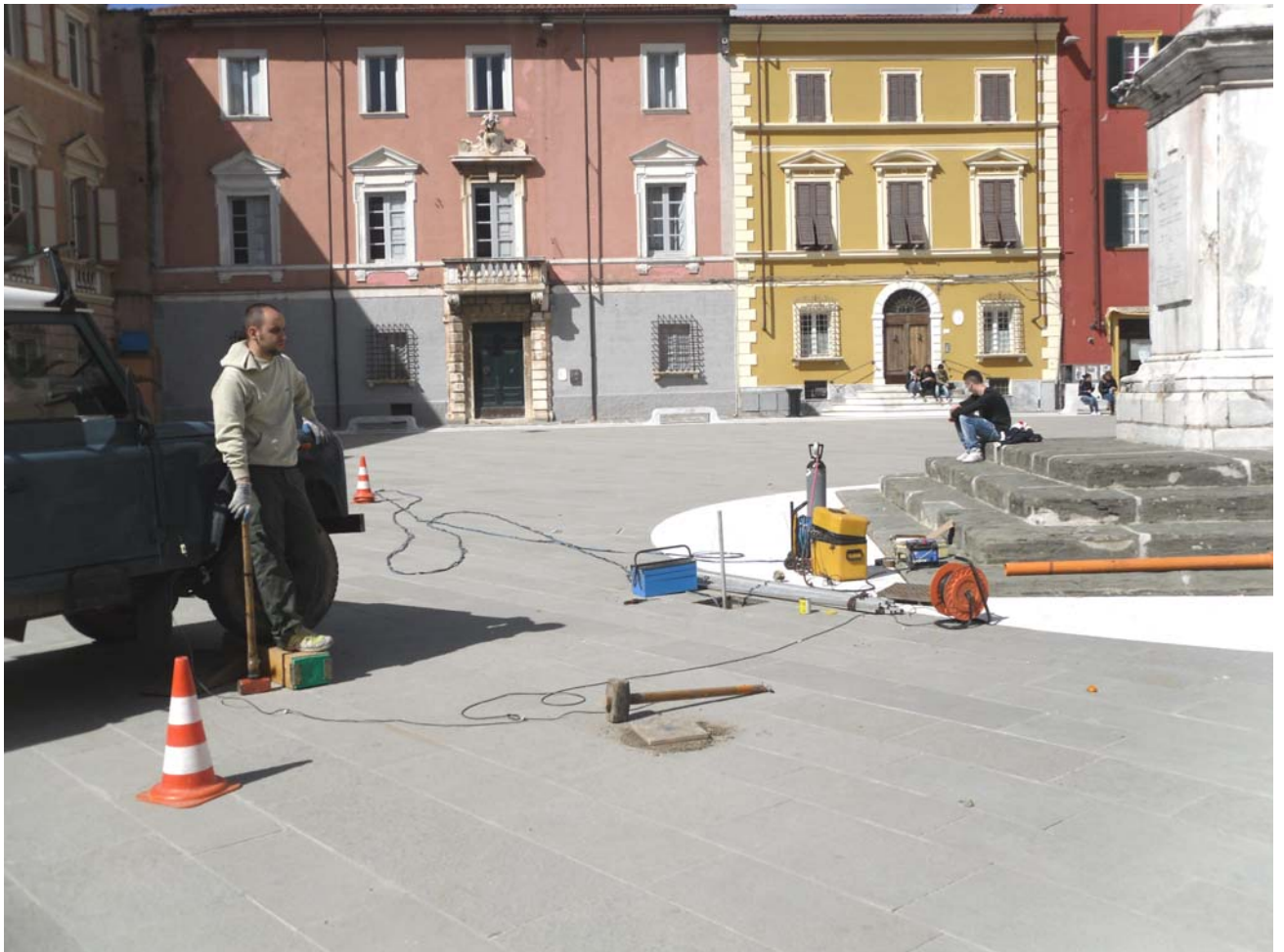
Foto 1 Esecuzione della prova sismica in foro tipo down-hole.
